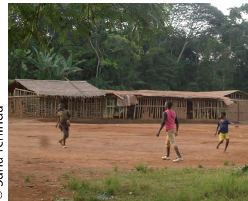
Figure 1. Ecole en terre battue au Sud du Cameroun
