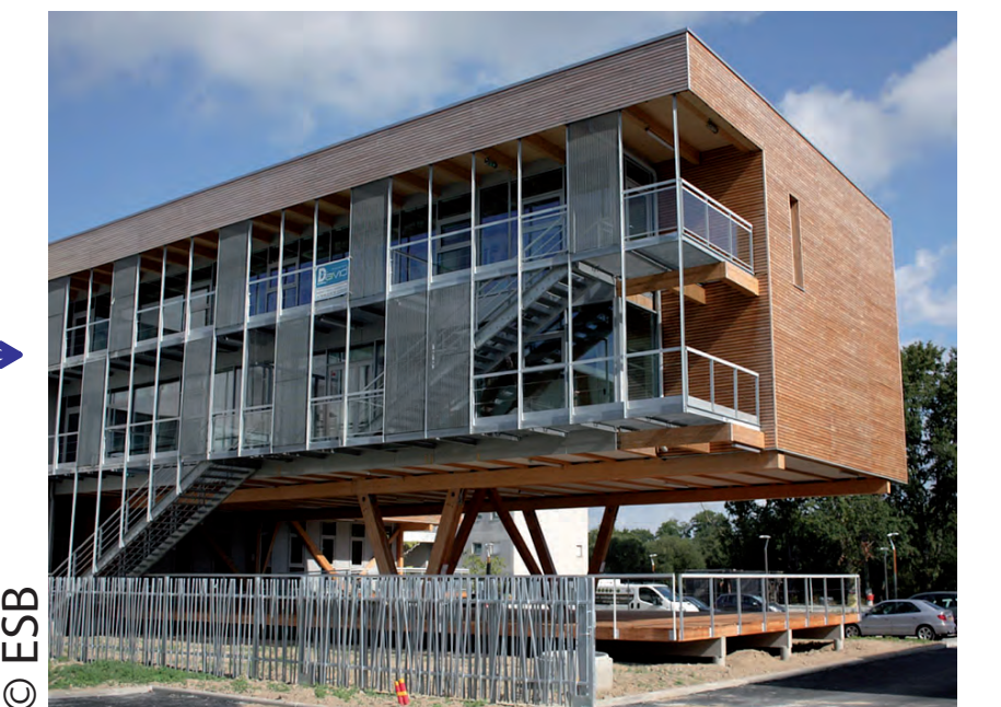
Figure 3. Ecole supérieure du bois de Nantes
