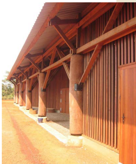
Porte en Moabi, poteaux en Tali, charpente en Kosipo, bardage à claire-voie en Mukulungu – Réalisation J.Y. Riaux, Mindourou (Cameroun).
