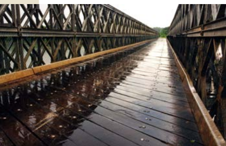
Platelage, pont sur la rivière Conté (Guyane française).
